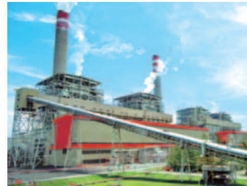
インドネシアで火力発電所の土木・建築工事を完了
