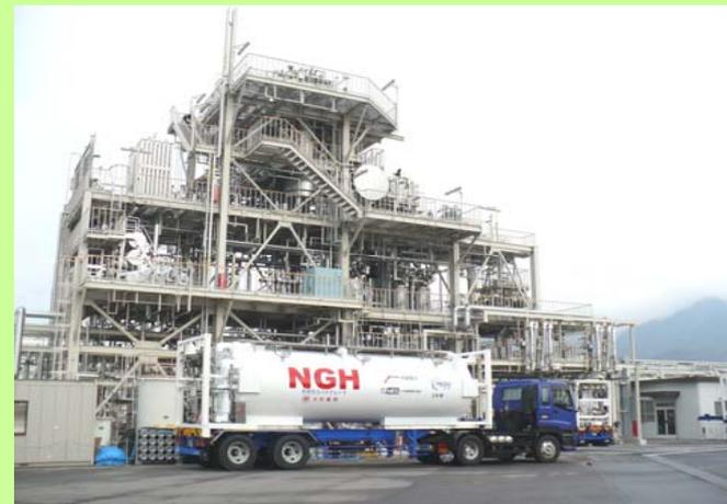
NGH生成能力確認試験により5トン／日を超える実績を確認。2010年度も、引き続きプロセス確認運転及び連続運転を実施し、商業化に必要な運転データを蓄積して行く。
