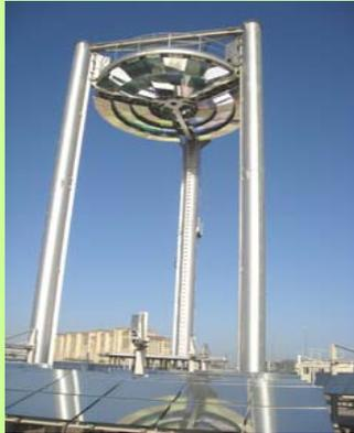
2009年10月に納入した反射式集光型太陽熱発電の実験プラントについて、性能評価試験を実施し、当初計画通りの集光性能を確認。
