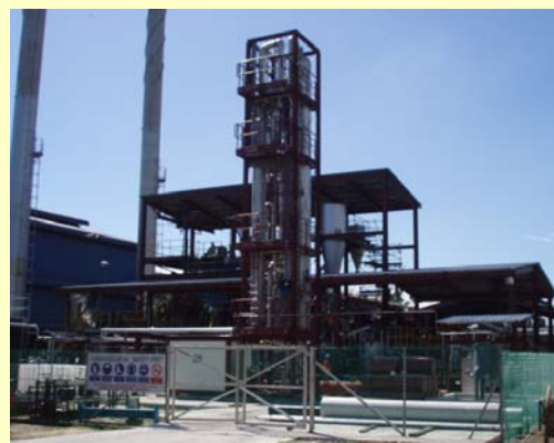
バイオエタノール 製造事業
