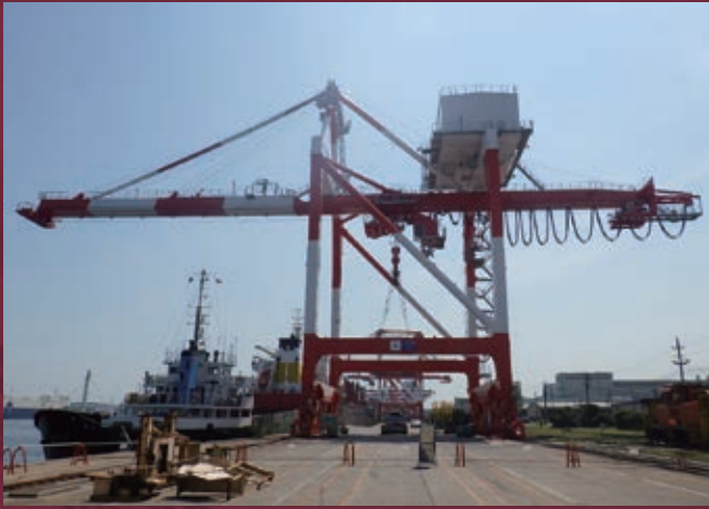
製品出荷用クレーン
