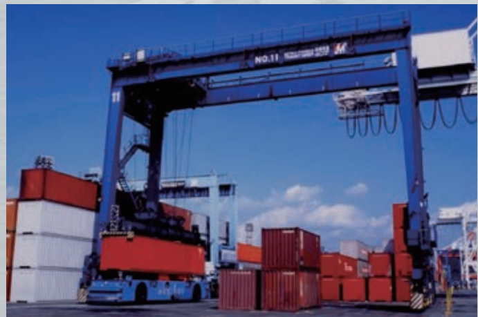
AGV、無人タイヤ式トランステーナー®、有人ポーテナー®による自動化ターミナル実証実験の成功
