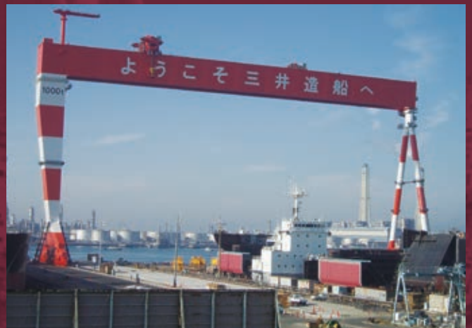
ゴライアスクレーン
