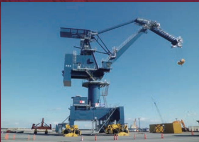
ダブルリンク式ジブクレーン
