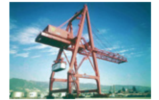
日本初の埠頭用コンテナクレーンが完成
