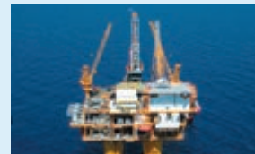
三井海洋開発㈱が設計・建造したメキシコ湾鉱区向けTLP（Tension Leg Platform：緊張係留式プラットフォーム）
