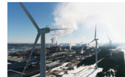
向浜風力発電所
