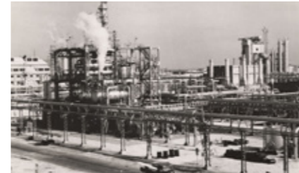
1958年 三井石油化学工業(株)岩国工場向けNo.1エチレンプラント
