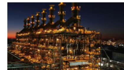
完成したエチレンプラント用分解炉
