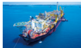
洋上石油・ガス生産
