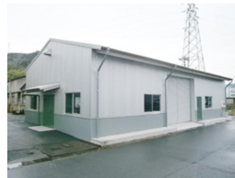
三井E&S玉野事業場に新設した実習棟
