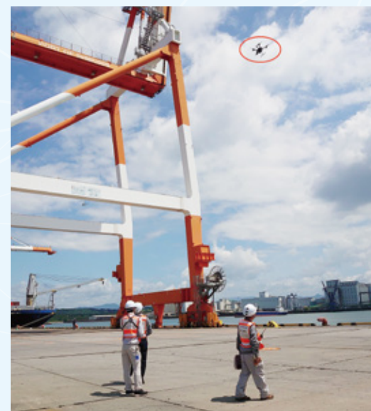
ドローン飛行による点検の様子
