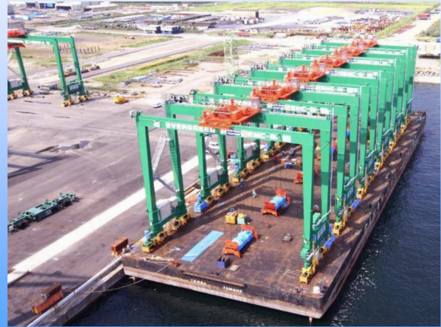
コンテナ用ヤードクレーン
