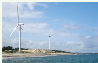
胎内風力発電所(竣工時)
