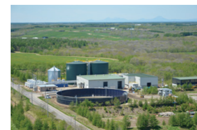
日本最大級のバイオガスプラント
