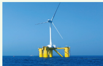
2MWダウンウィンド型浮体式洋上発電設備「ふくしま未来」
