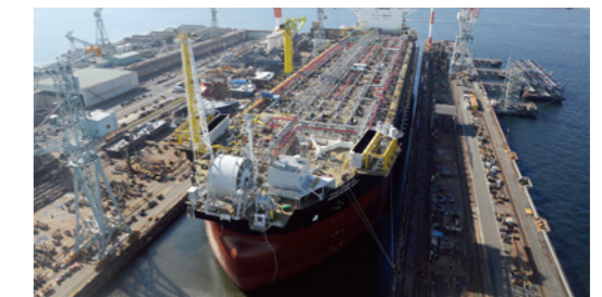
2015年 浮体式海洋石油・ガス生産貯蔵積出設備 (FPSO) 船体部を建造
