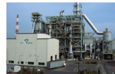
バイオマス発電プラント
