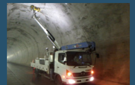
トンネル覆工コンクリート調査
