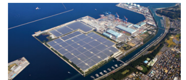
大分日吉原太陽光発電所全景
