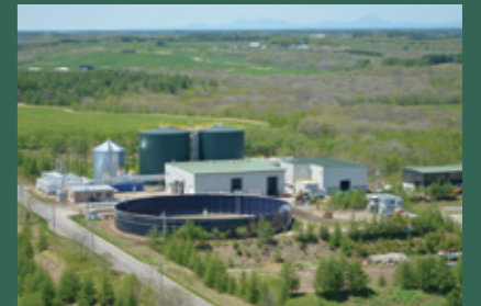
別海バイオガス発電プラント
