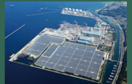
大分日吉原太陽光発電所全景
