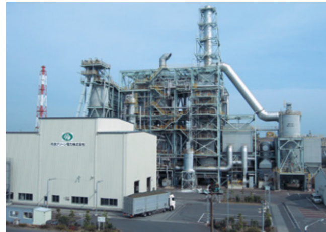
三井造船千葉事業所(千葉縣市原市)内の発電設備
