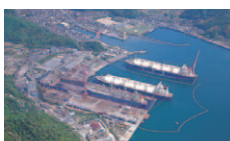
由良修繕部・鉄構部
