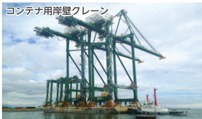
コンテナ用岸壁クレーン
