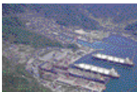
由良修繕部・鉄構部
