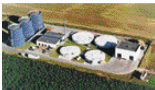
バイオガスプラント
