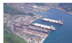
由良修繕部・鉄構部
