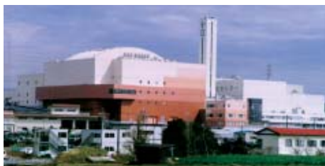
国内最大級のガス化溶融型都市ごみ処理施設完成
