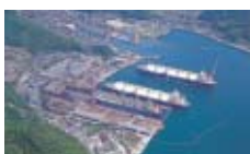
由良修繕部・鉄構部
