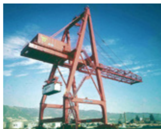
日本初の埠頭用コンテナクレーンが完成
