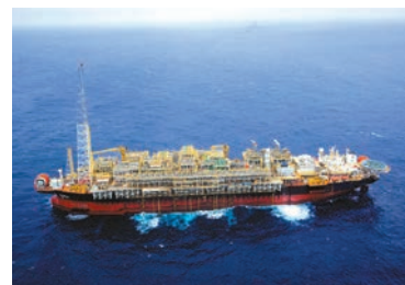
ブラジル沖合で稼働中の "FPSO Cidade de Mangaratiba MV24"
