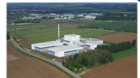
英国向けバイオマス発電プラント
