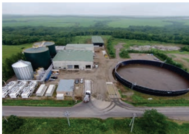
写真3 別海バイオガス発電株式会社 全景
