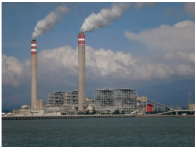
写真4 タンジュン・ジャティ B Unit1&2 石炭火力発電所 全景
