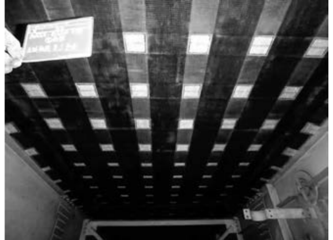
写真2 炭素繊維シート貼付状況
