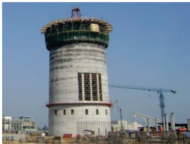
写真5 スリップフォーム工法
