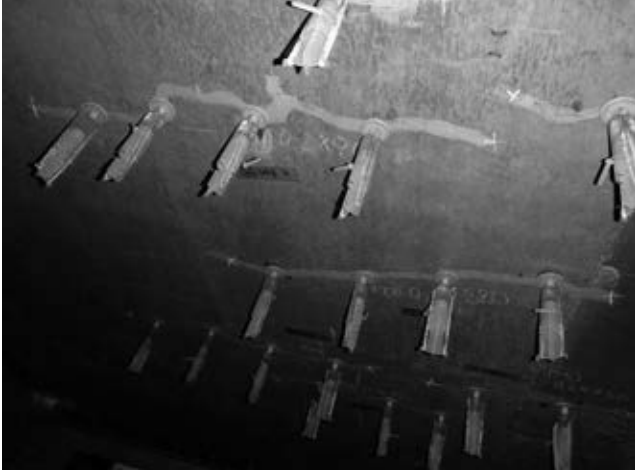
写真1 樹脂注入状況
