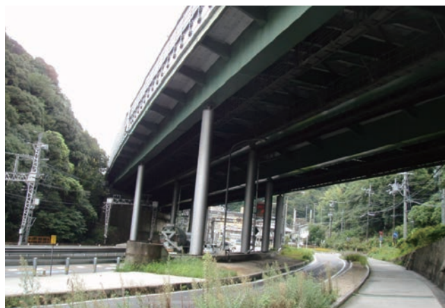
写真 8 地震対策前の追分橋
