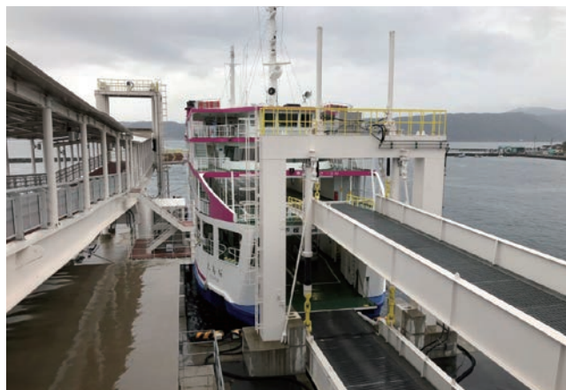
写真 16 桜島可動橋（一期工事）
