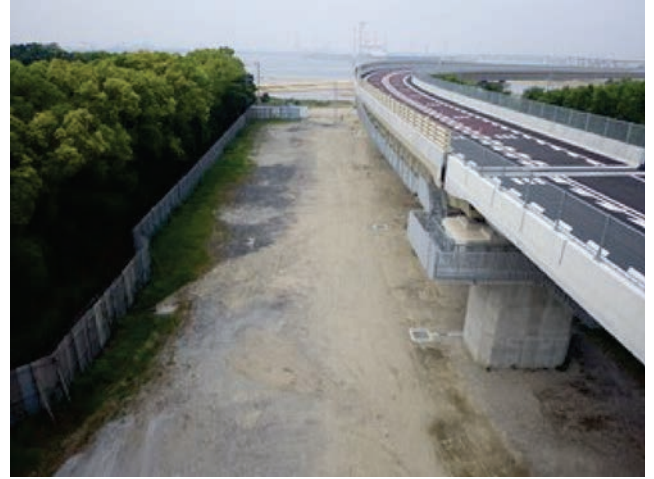
写真2 霞 4 号橋梁（工事完成時）
