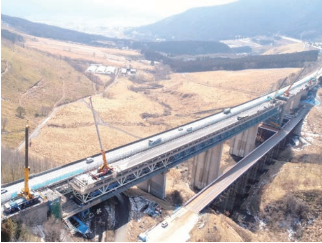
写真1 鋼部材及び床版の取替（下り線施工時）
