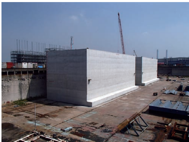
写真14 釜石港防波堤ハイブリッドケーソン
