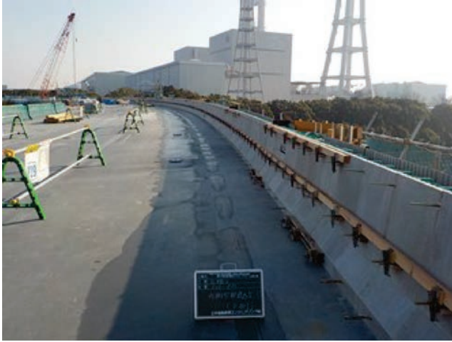
写真1 壁高欄施工状況（埋設型枠設置）
