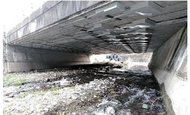
写真20 アウトプレート工法
