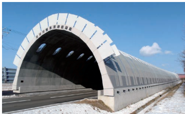
写真 16 スノーシェルター
