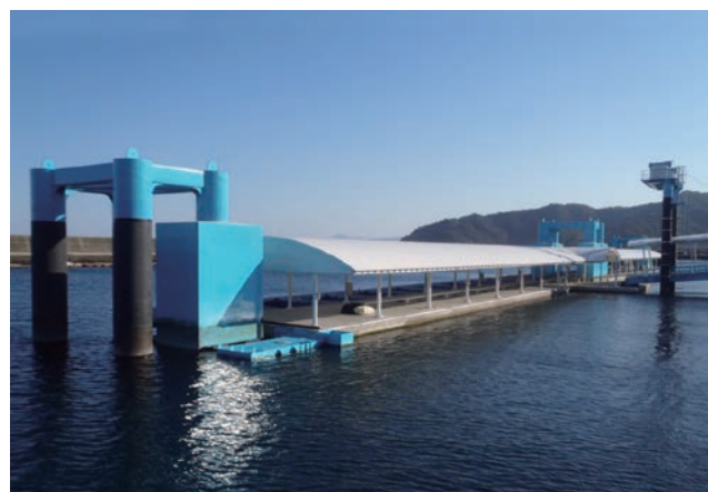
写真 10 佐賀関漁港浮棧橋
