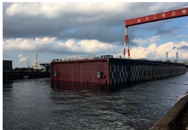
写真 17 東京港臨港道路南北線沈埋函の出渠
