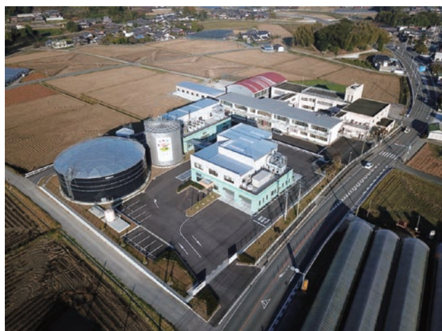
写真3 みやま市バイオマスセンター
