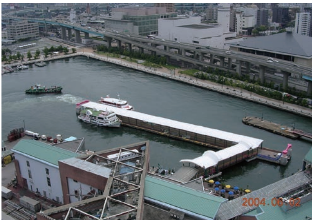
写真 11 博多港浮棧橋
