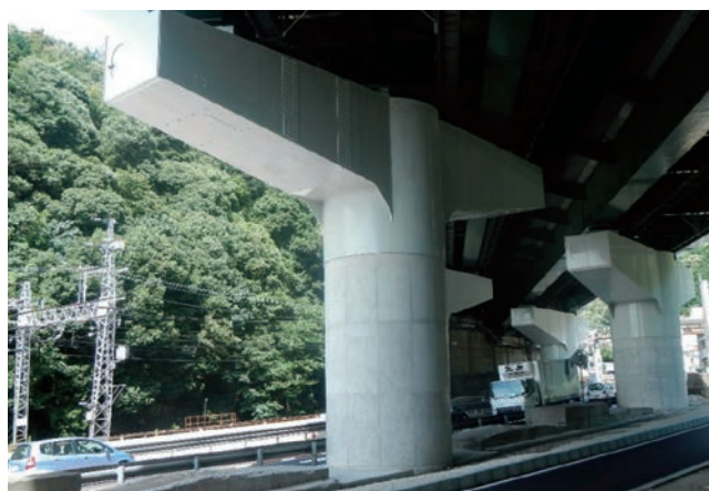
写真 9 地震対策後の追分橋
