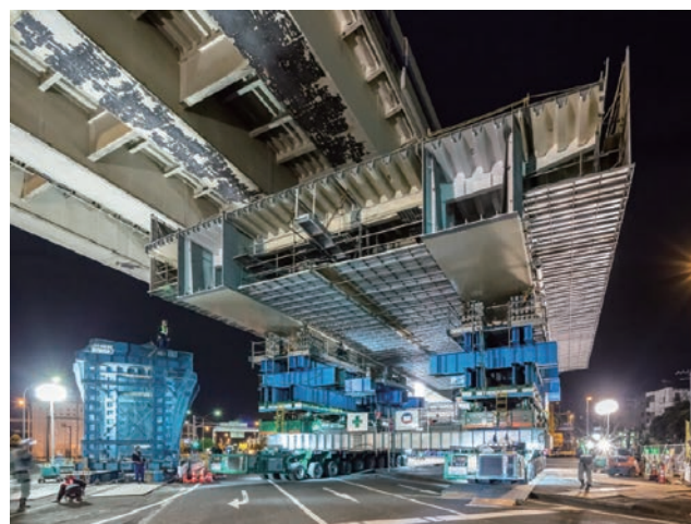
写真5 多軸台車による鋼桁運搬
