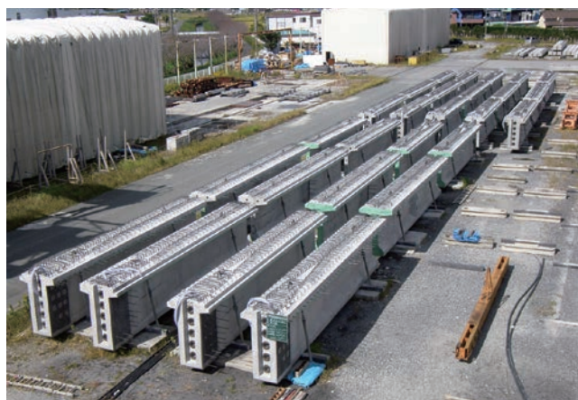
写真4 ポストテンションセグメント桁
