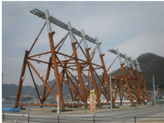
写真15 尾道糸崎港防波堤用ジャケッ
