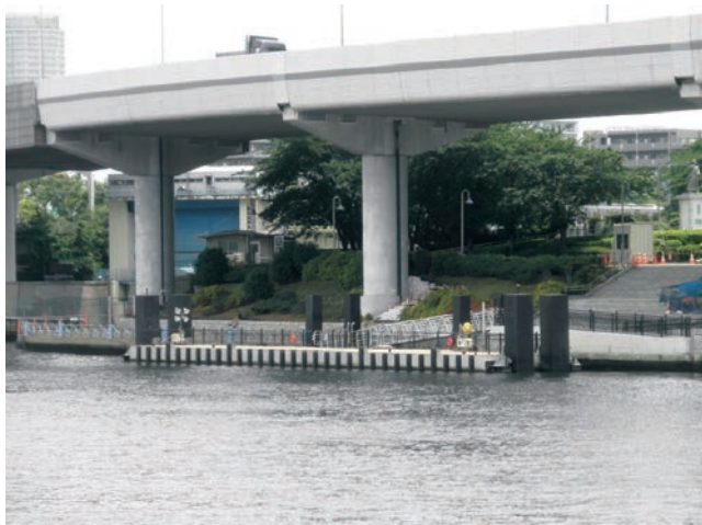
写真13 墨田区吾妻橋浮棧橋
