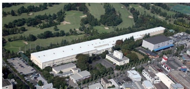
写真1 三井造船昭島研究所全景
