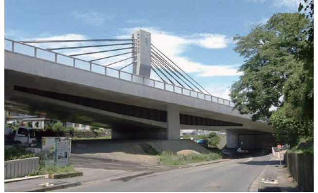
写真14 荒巻本沢大橋
