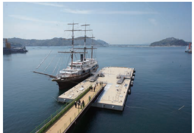
写真 12 福良港津波対応型浮棧橋
