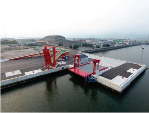
写真1 “東予港可動橋” の完成写真
