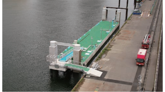
写真3 3号基完成写真
