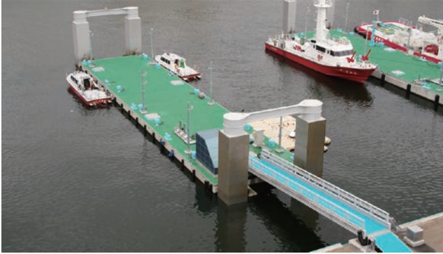
写真1 1号基完成写真
