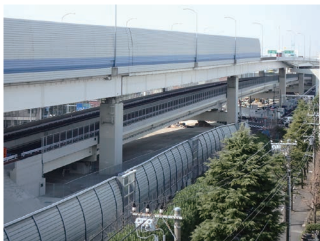
写真4 本牧地区7・8号橋
