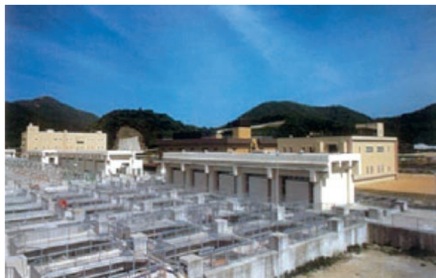
写真 1 児島湖流域下水道浄化センター
