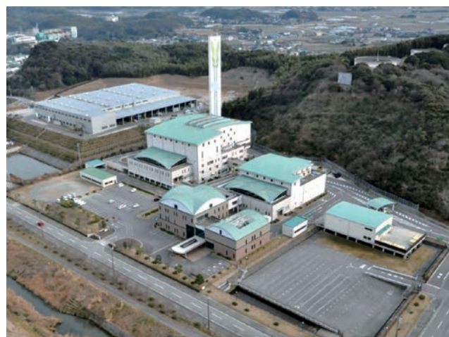
写真4 西尾市クリーンセンター(流動床炉)
