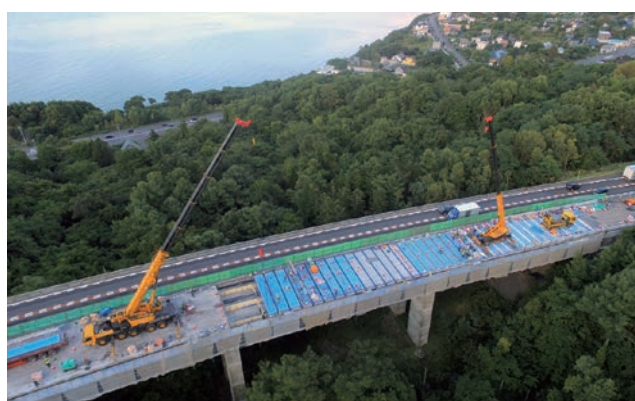
写真 19 大野橋床版取替工事
