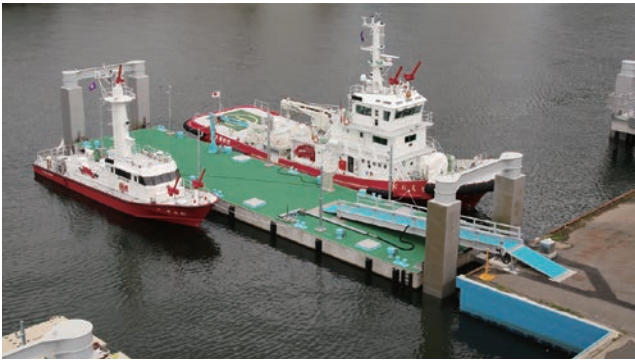
写真2 2号基完成写真
