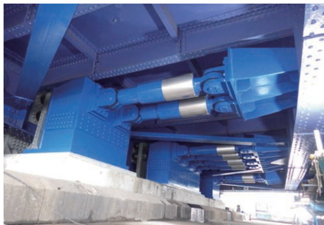
写真7 ダンパー設置後の状況
