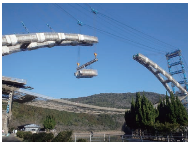
写真3 アーチリブ架設
