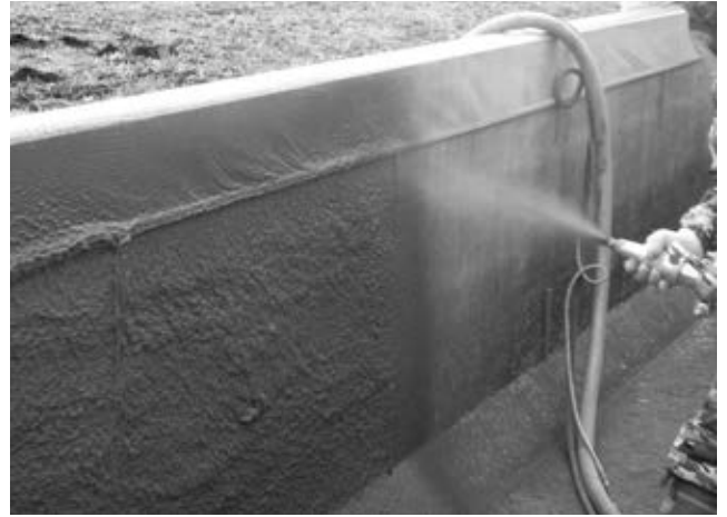
写真2 水路の断面修復(吹付け工法)
