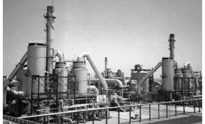
写真4 モロッコ王国 / OCP 向け 2300 t/d x 6 系列硫酸プラント
