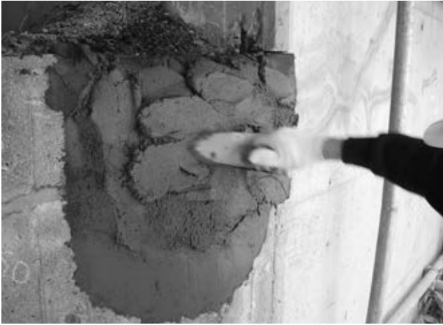
写真1 橋台の断面修復(コテ塗り工法)
