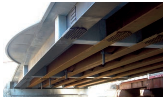
写真 MDブリッジ(東京都、町田橋)
