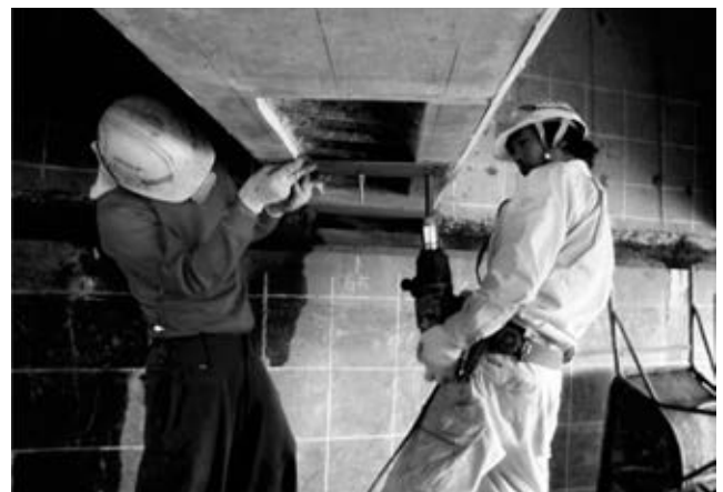
写真 アンカーボルト設置状況 Setting of Anchor Bolt
