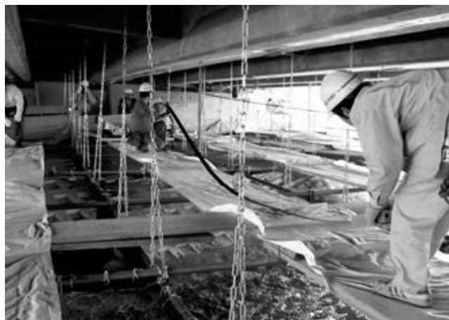
写真 アウトプレート設置状況 Setting of CFRP Plate
