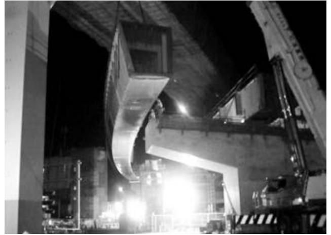
写真 2 夜間架設の状況
