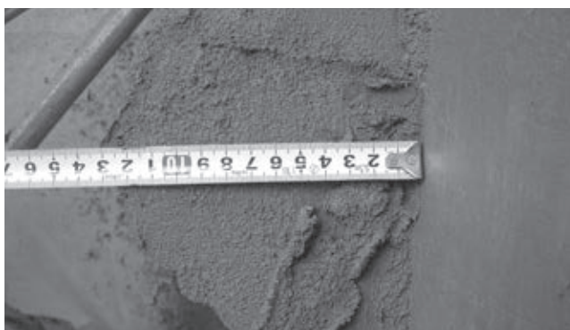
写真4 吹付け後の壁面(なおしたルN) Wall Surface after Spraying(NAOSHITARU-N)
