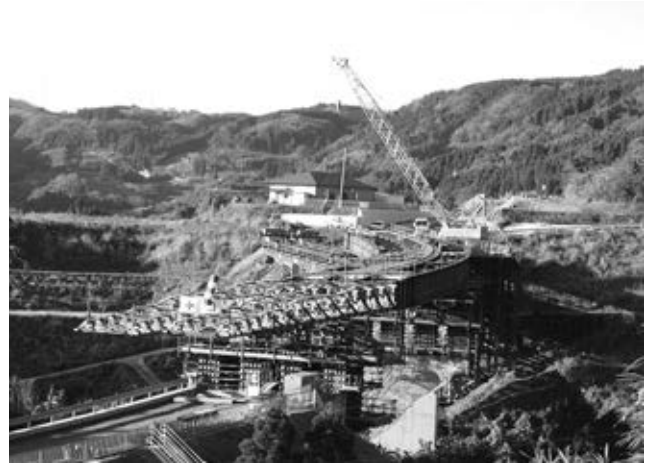
写真2 送り出し架設状況
