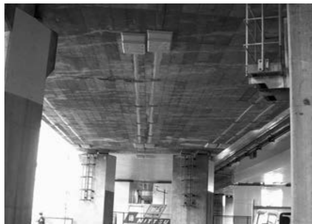
写真 補強の完成 Completion of Reinforcement
