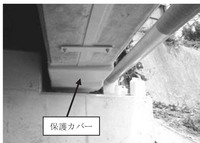
写真 保護カバー設置状況 Setting of Protective Cover
