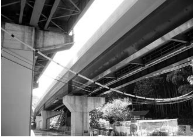
写真1 完成時全景(手前は既設橋)
