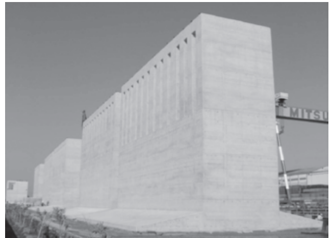
写真 2 ケーソン製作完了写真(当社千葉事業所)
