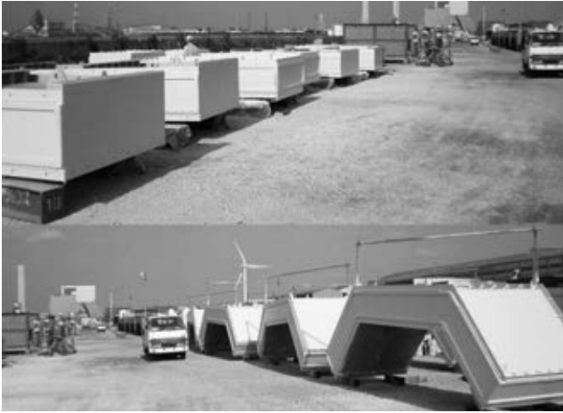
写真1 鋼製函体ユニット
