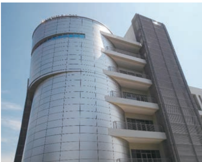
(a)ジャカルタのBP31P校(6階建てビルの4階に操船シミュレータを設置)
