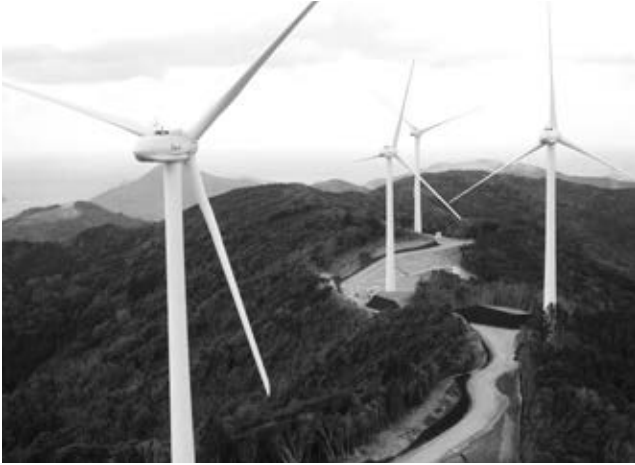
写真1 由良風力発電所1号機～4号機(竣工時)
