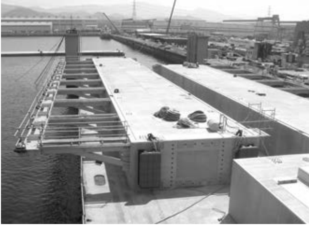
写真 1 製作状況(正面：西側，右端：東側)
