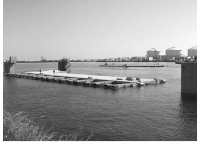
写真 2 進水状況(手前：東側，奥：西側)
