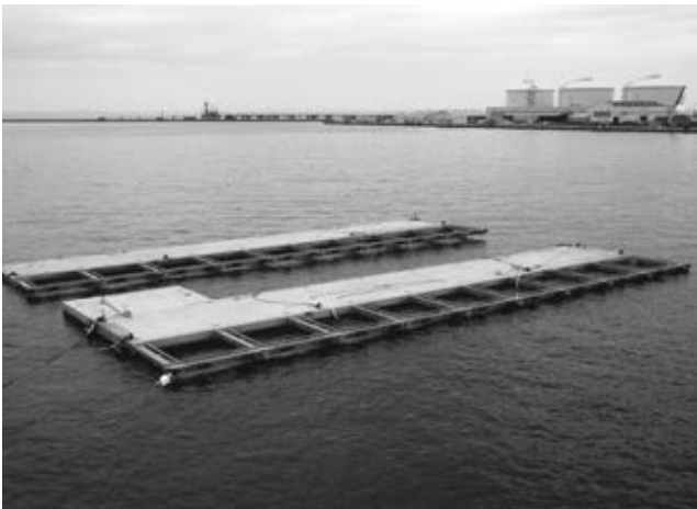
写真 3 浮棧橋全景(上：西側，下：東側)
