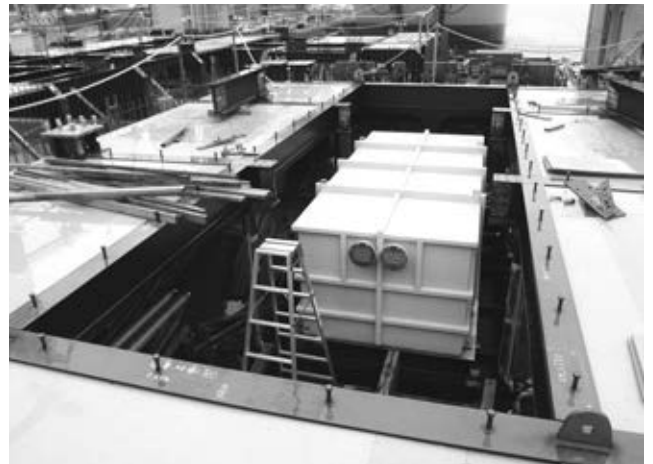
写真 4 排水槽設置状況(西側)
