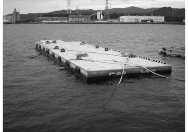
写真5 浮棧橋(25 x 8 m)全景
