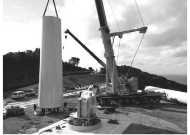
写真2 由良風力発電所(現地据付時)
