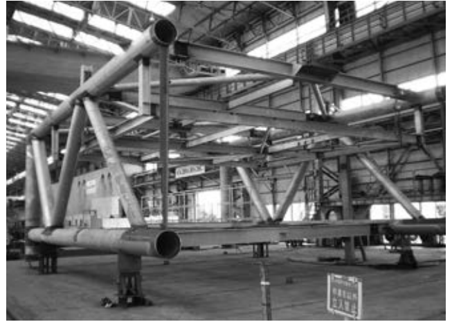
写真3 鋼管トラス製作状況2
