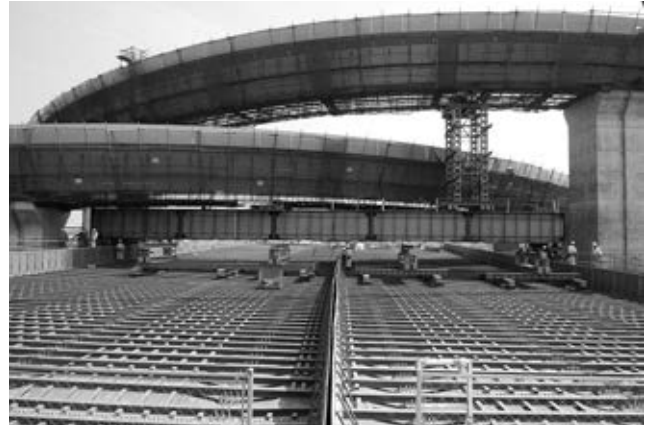
写真2 本線橋を跨ぐ門型ベント
