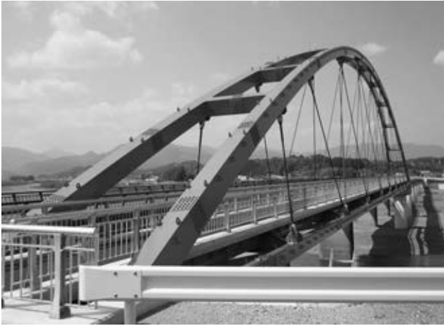
写真1 完成した森永歩道橋
