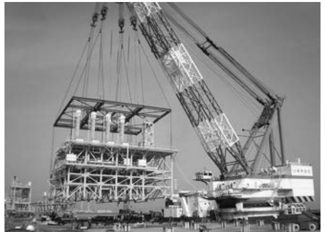
写真5 NB架構積込
