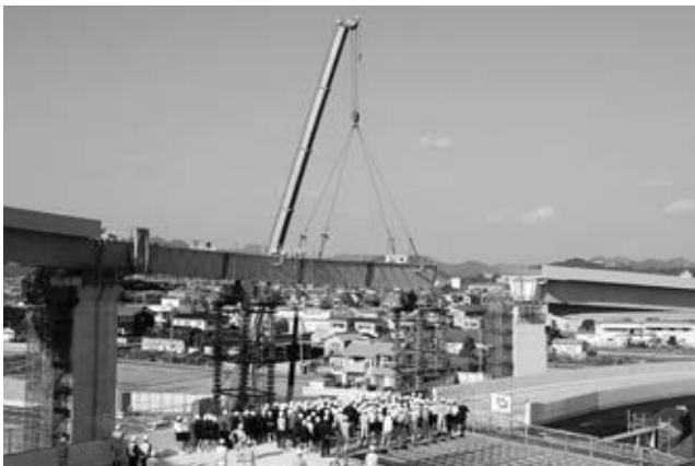
写真5 Bランプ橋架設状況
