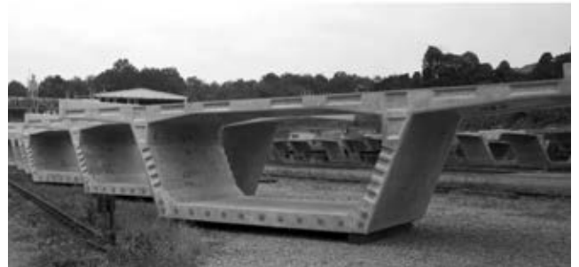
写真2 標準セグメントの仮置き状況
