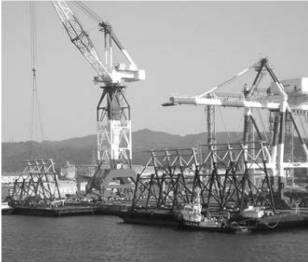
写真1 完成したジャケットを台船に搭載している状況
