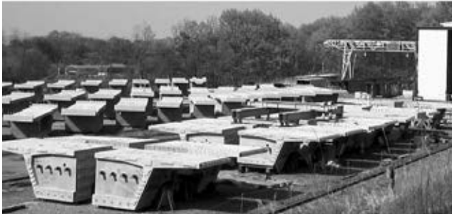
写真1 端部セグメントの仮置き状況
