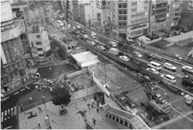
写真 1 3期施工部の旧橋撤去作業状況
