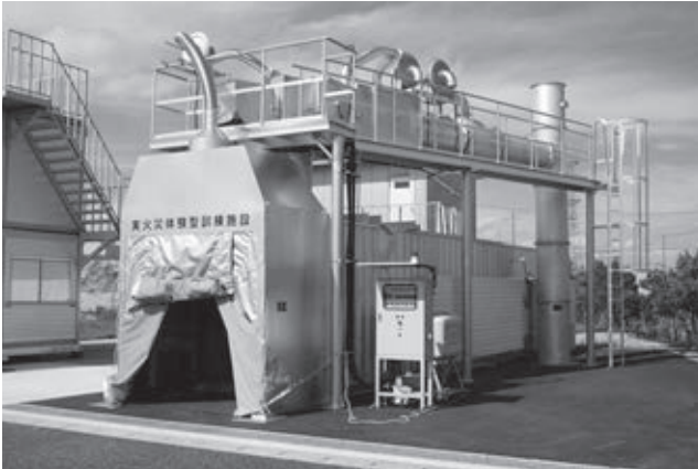
写真1 鳥取県消防学校向け濃煙熱気実火災訓練装置
