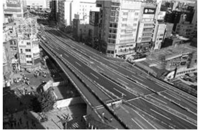
写真 2 架替完了後の新宿高架橋
