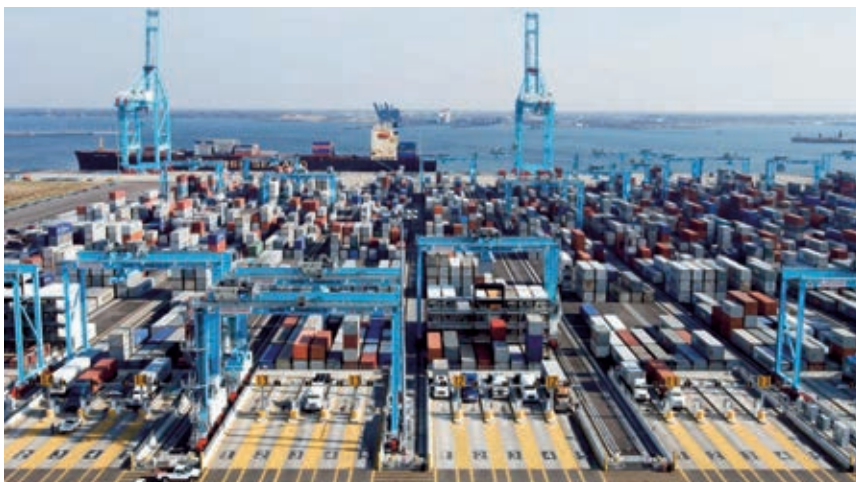
写真1 ASC方式の自動化コンテナターミナル(米国バージニアのAPMTターミナル) Automated Container Terminal Operated with ASCs
