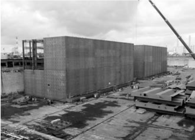
写真1 ケーソン内部鋼殻の製作完了写真
