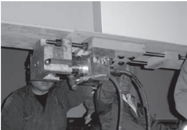
写真1 緊張作業状況
