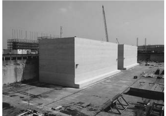
写真2 ケーソン製作完了写真(竣工時)
