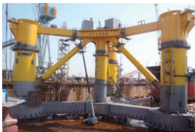
写真9 実証試験用浮体の製作状況
