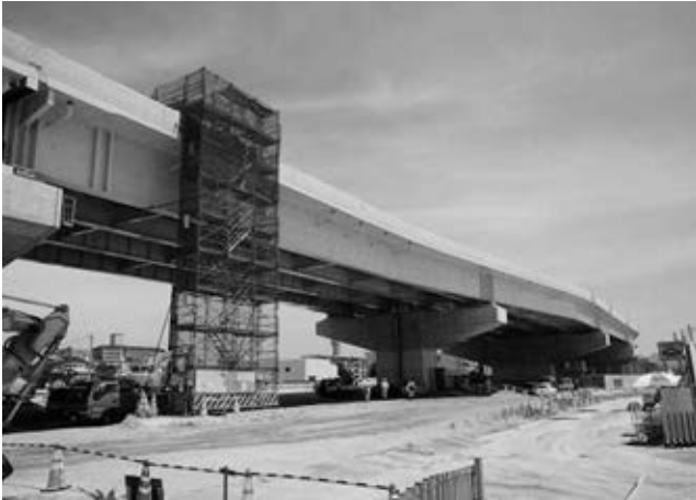
写真1 架橋後の全景
