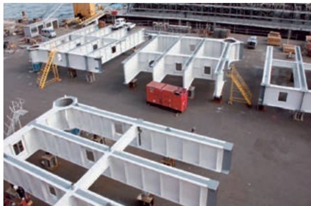
写真 37 羽田空港向けジャケット上部(ブロック製作状況)
