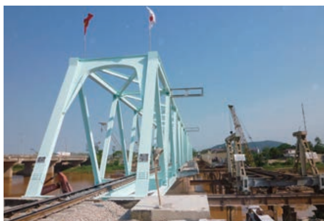
写真 19 Do Len 橋の架設状況(第三期工事の1B工区)
