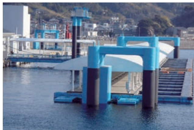
写真32 佐賀関漁港浮棧橋(2函の浮棧橋を岸壁に並行配置)
