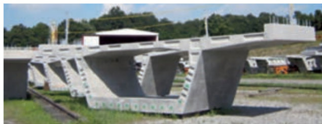
写真30 標準セグメントの仮置き状況
