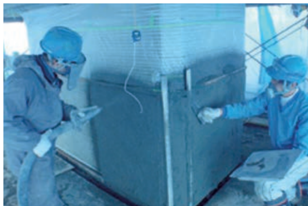
写真 45 吹き付け工法
