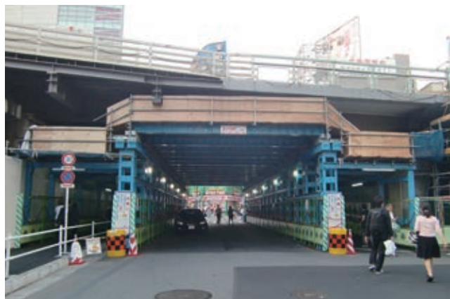
写真 24 ベントを使用した防護構造
