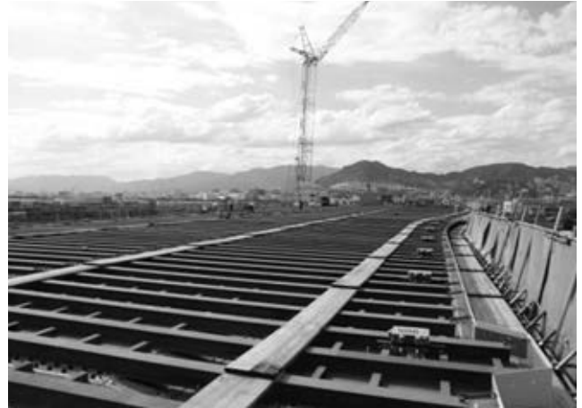
写真2 “MESLAB”の施工状況
