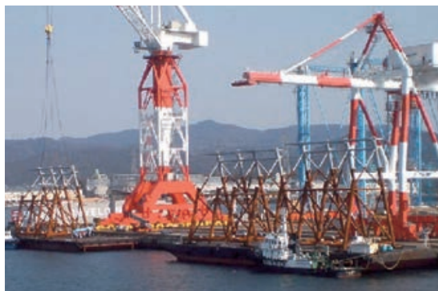
写真 36 尾道糸崎港向けジャケット(台船に搭載している状況)
