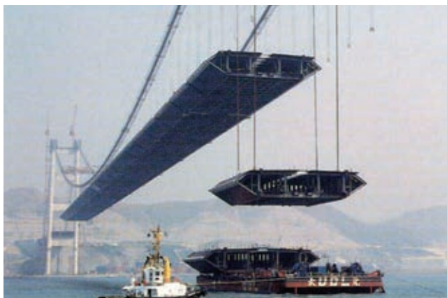
写真 15 青馬大橋の架設状況
