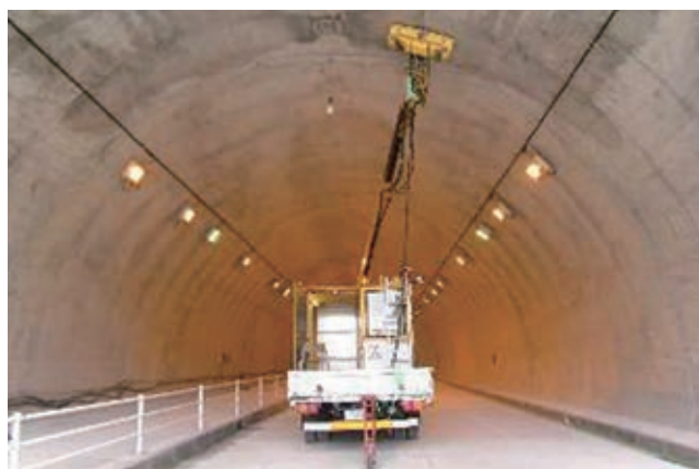
写真 41 トンネル覆工調査
