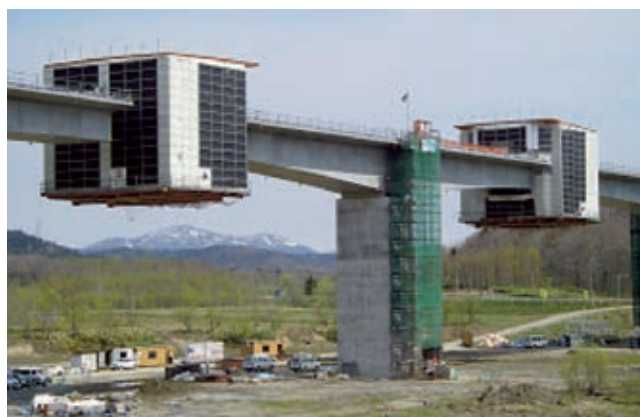
写真 26 望郷橋の張出し施工状況
