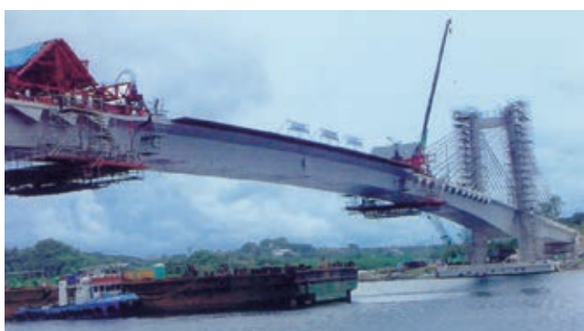
写真 16 日本・パラオ友好橋の架設状況
