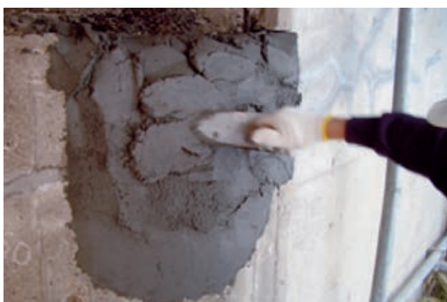
写真 44 小手塗り工法
