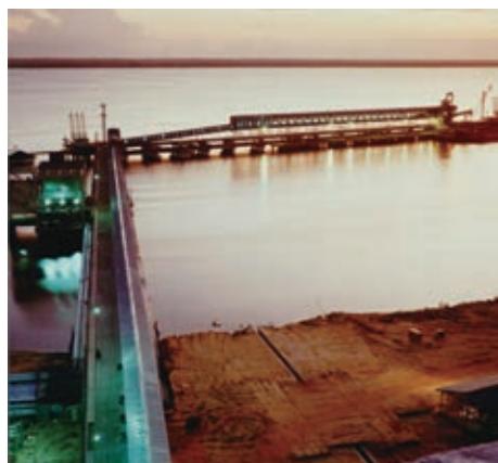
写真10 ドュマイ製油所棧橋建設工事
