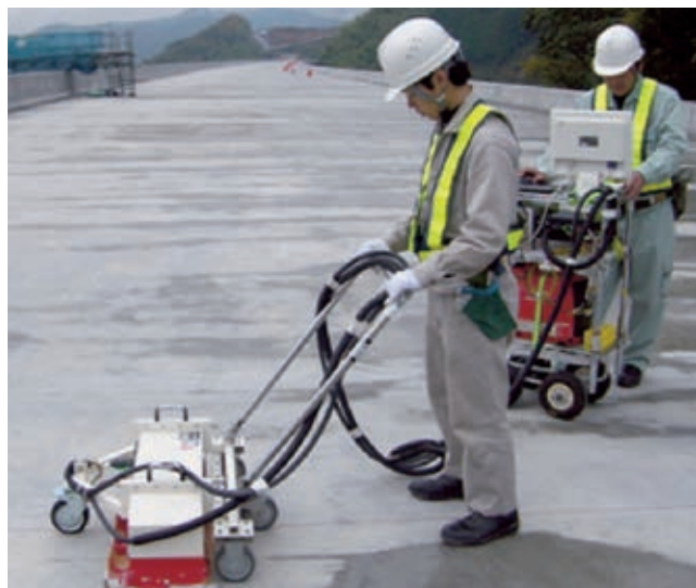
写真 40 グラウト充填確認調査状況
