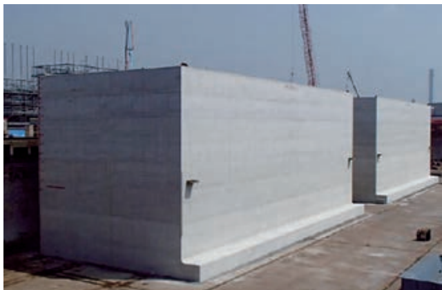
写真 35 釜石港向けケーソン
