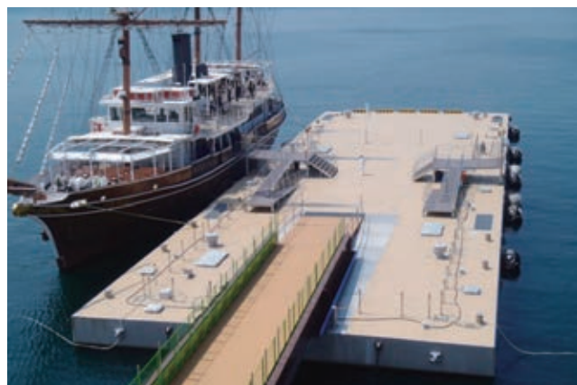
写真31 福良港浮棧橋
