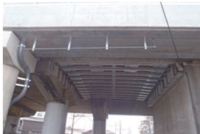
写真42 アウトプレート補強完了後のP2～A2径間状況
