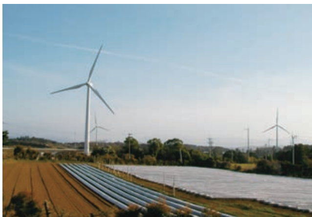
写真2 肥前南風力発電所
