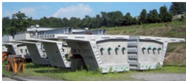
写真29 端部セグメントの仮置き状況
