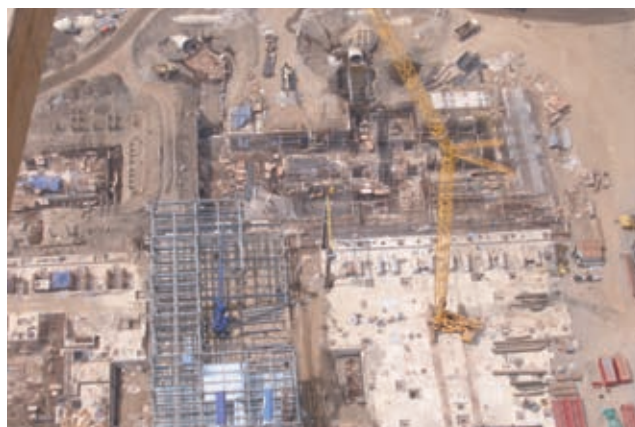
写真11 タンジュン・ジャティB石炭火力発電所1&2号機建設工事
