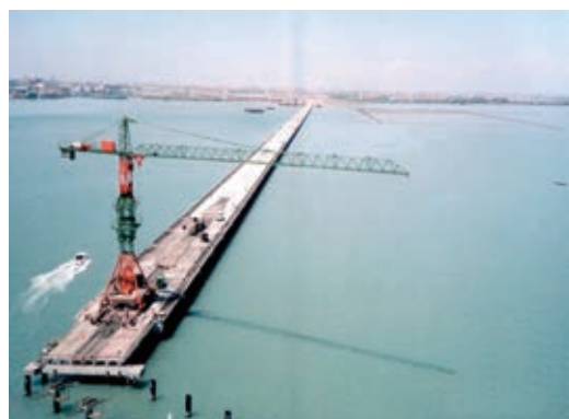
写真12 スラバヤ港棧橋工事
