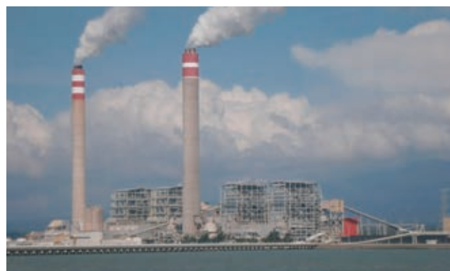
写真13 タンジュン・ジャティ B 石炭火力発電所建設工事
