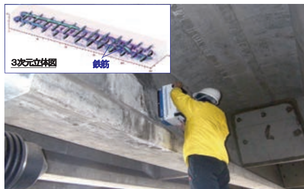
写真39 マルチパッシブアレイレーダ装置による調査状況
