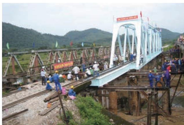
写真 20 Ke Net 橋の横取り架設状況(第三期工事の1C工区)
