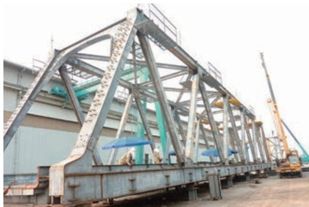
写真 18 MTSC 社における仮組立状況
