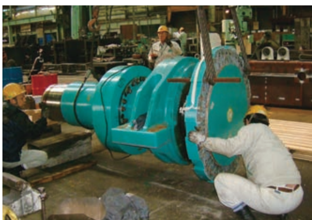
写真5 1.5MW ギヤボックスの補修状況
