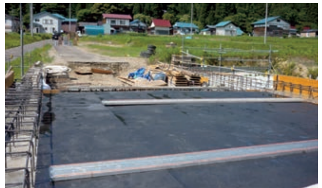
写真4 コンクリート養生マットの敷設状況 Concrete Curing Mat Placed
