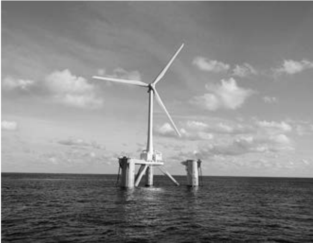
写真1 2 MW 風力発電施設“ふくしま未来”
