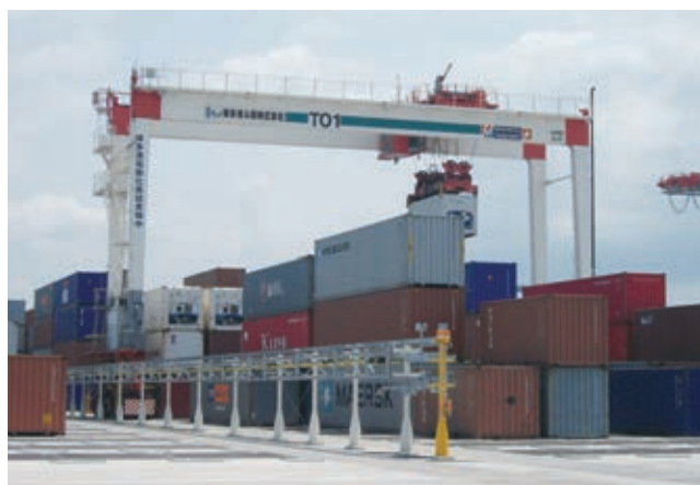
写真12 バスバー給電式電動型トランスレーナ
