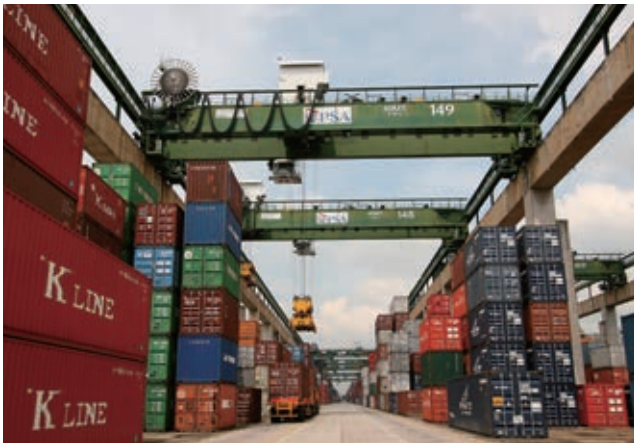
写真 15 OHBC を採用したコンテナターミナル
