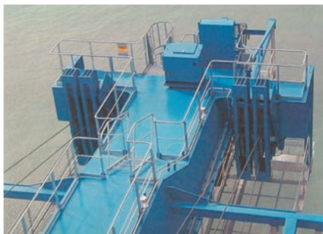
写真6 ガーダ後端部
