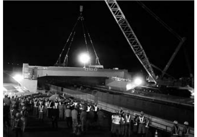
写真2 一括架設の施工状況
