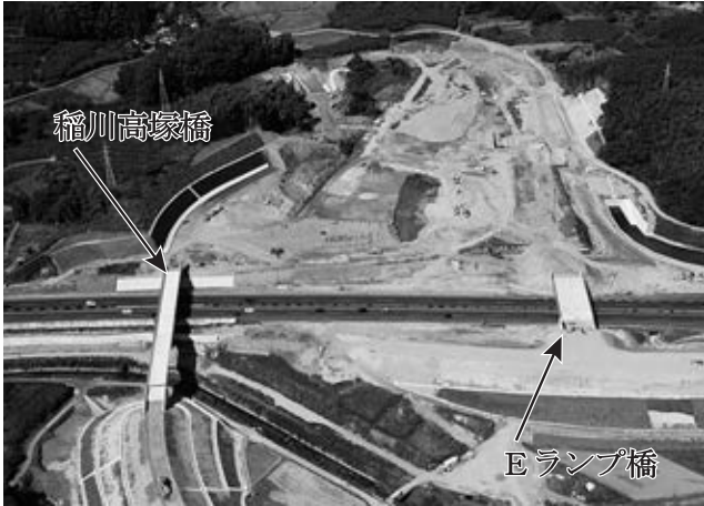
写真1 架橋後の全景
