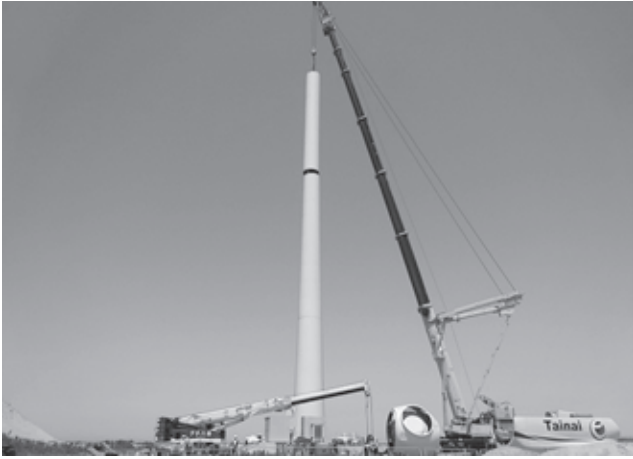
写真1 胎内風力発電所(据付時)
