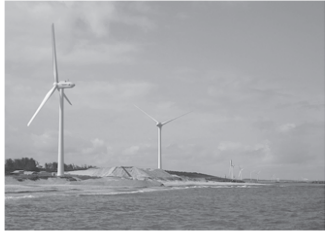
写真2 胎内風力発電所(竣工時)
