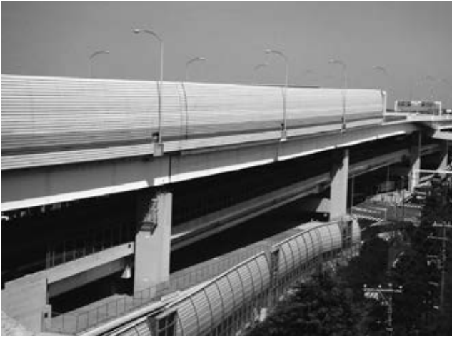
写真1 本牧7・8号橋の全景
