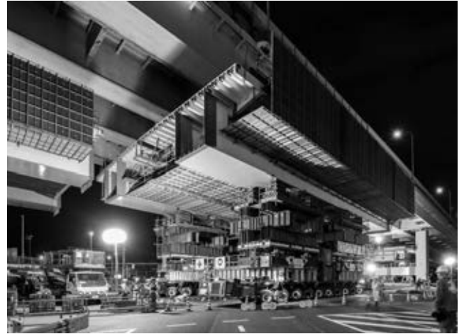
写真2 多軸式特殊台車による架設状況
