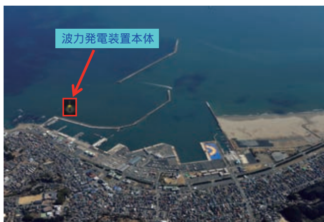
写真2 設置場所(大洗港) Installation Location(Oarai port)
