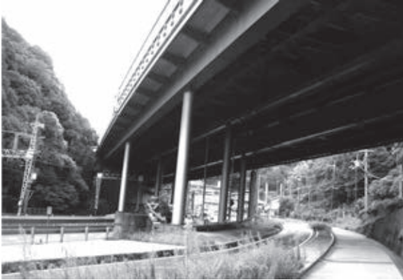
写真1 既設橋脚(ロッキング橋脚)
