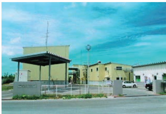
写真1 施設外観 External View of the Plant
