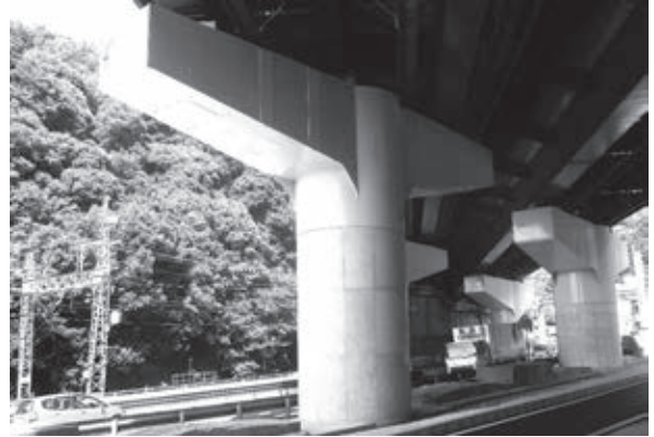
写真2 更新後の橋脚
