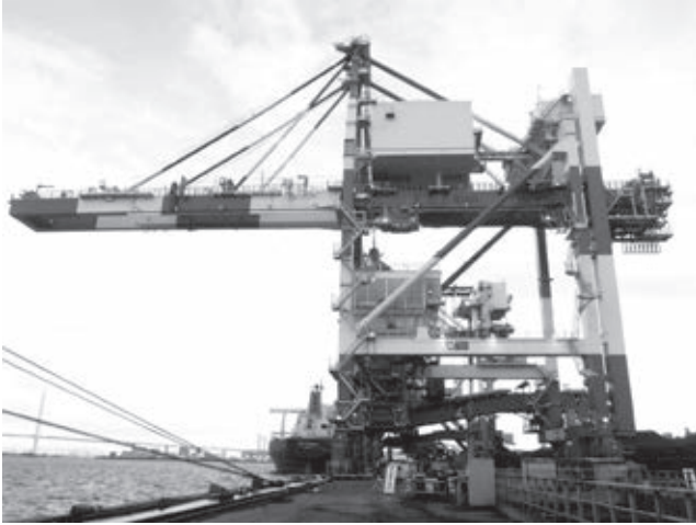
写真1 アンローダ全景
