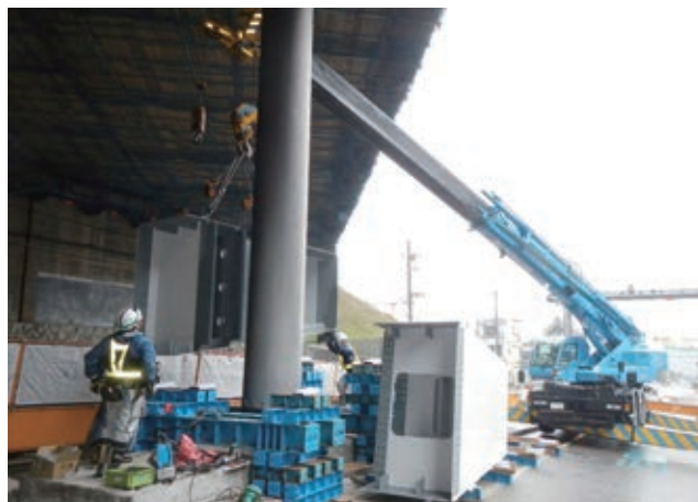
写真4 貫通ブロック(鋼製梁先端部)架設 Construction of Through Block(Tip of Steel Beam)
