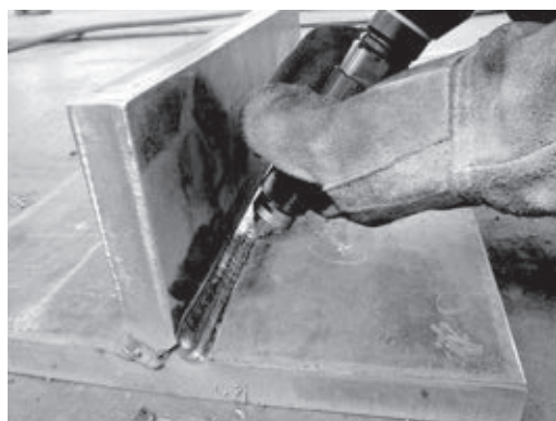
(a)施工状況
