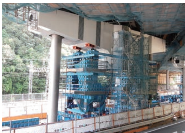
写真7 鋼製梁ジャッキアップ Jack Up of Steel Beam
