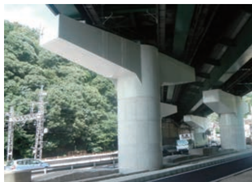
写真2 更新後の追分橋 Oiwake Bridge after Reinforcement
