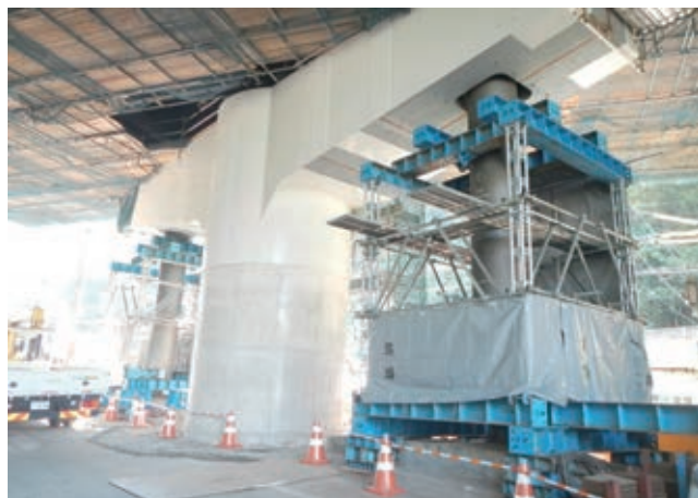
写真9 既設ロッキング橋脚の撤去 Removal of Existing Rocking Piers
