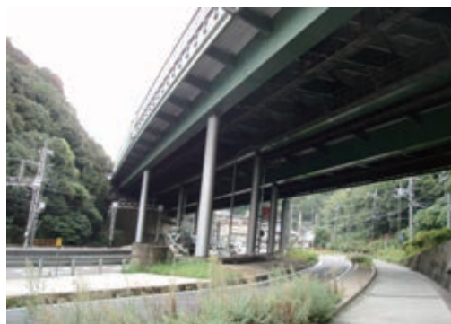
写真1 更新前の追分橋 Oiwake Bridge before Reinforcement
