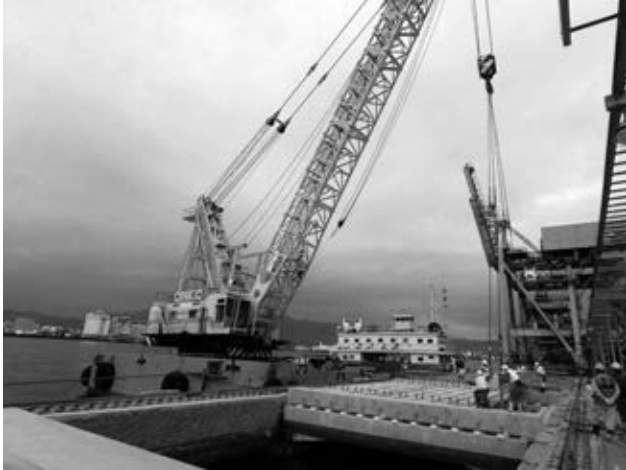
写真1 主桁架設状況
