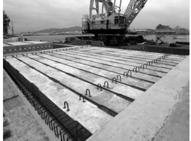
写真2 主桁架設完了
